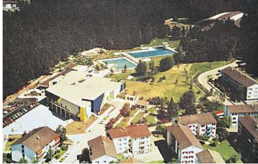
Mit dem neuen Freibad Schluefweg entstand 1977/78 auch die Eishalle. Bilder: pd
